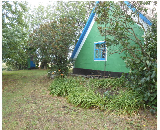
Фото: Побутове приміщення НСП № 12
