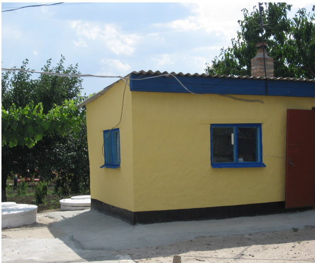
Фото: Побутове приміщення НС № 11
