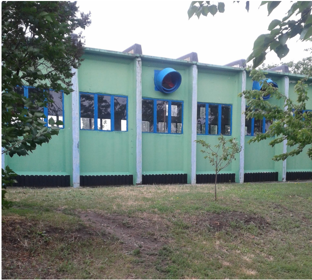
Фото: Насосна станція НСП № 12
