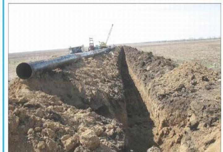
Хозяйство собственными силами проводит замену стальных трубопроводов диаметром 420 мм с переходом на пластиковый трубопровод диаметром 350 мм и 225 мм, который обеспечит работу двух дождевальных машин "Фрегат". Работа по пайке пластиковых трубопроводов диаметром 225 мм выполнялась работниками нашего управления, что позволило дополнительно заработать средства для управления.
