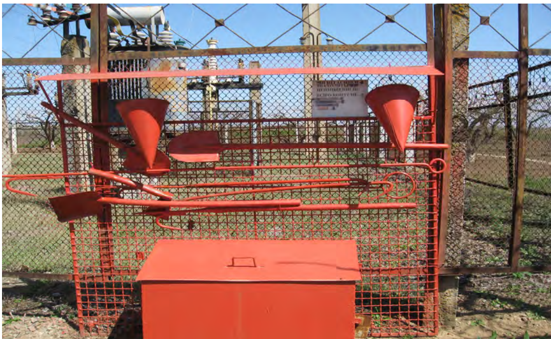
Фото: Трансформаторна підстанція насосної станції №10
