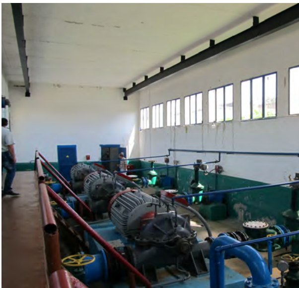
Фото: Машинний зал НС № 4 каналу 3 МК
