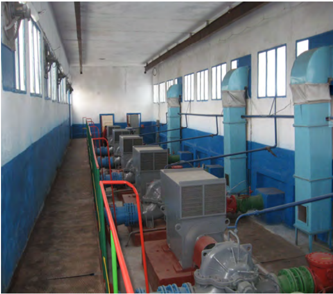
Фото: Машинний зал насосної станції №10 Приазовського МК
