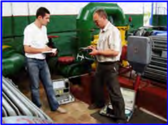
Проведення робіт по виміру напірно-витратних насосних агрегатів
