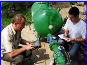
Проведення вимірювальних робіт по визначенню достовірної роботи приладів водообліку
